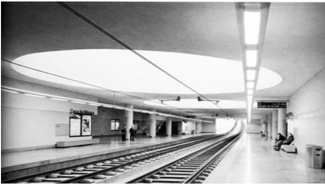
Imagen No. 9 Interior de la Estación Casa da Música del Metro de Oporto Fuente: El metro como proyecto urbano (9/10/2012) Presentación PhD Rocío Hidalgo Universidad Católica de Chile
